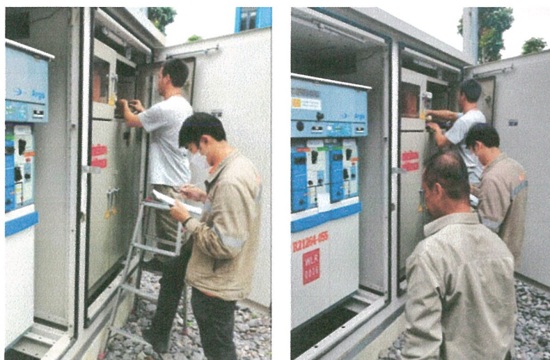
รูปภาพที่ 2.53 การตรวจสอบหม้อแปลงไฟฟ้า
