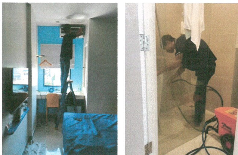
รูปภาพที่ 2.33 การล้างทำความสะอาดเครื่องปรับอากาศ
