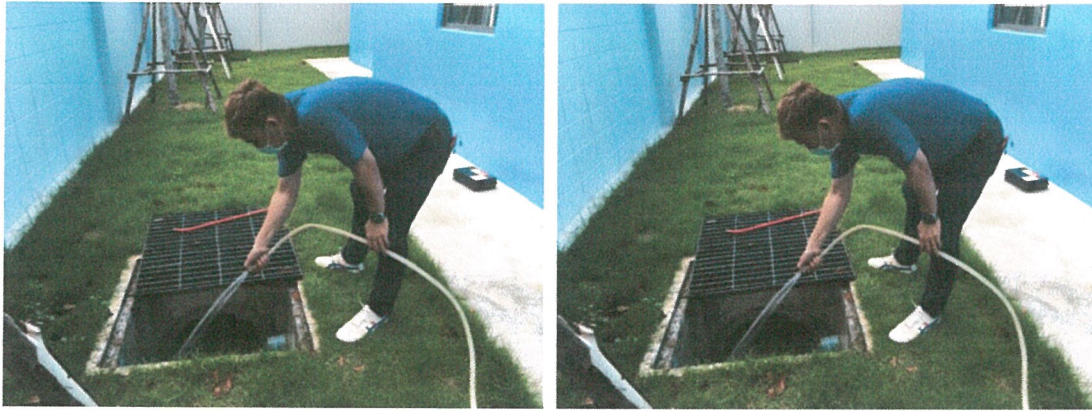
รูปภาพที่ 2.48 การขูดลอกตะกอนในรางระบายน้ำ
